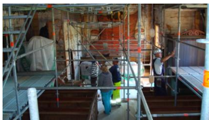
Ställningsbygge pågår i kyrkan.
